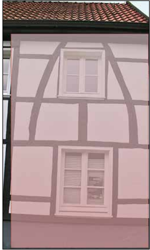
Wohnhaus Kellerstraße 10, im rosa gekennzeichneten Teil befand sich die Nagelschmiede
